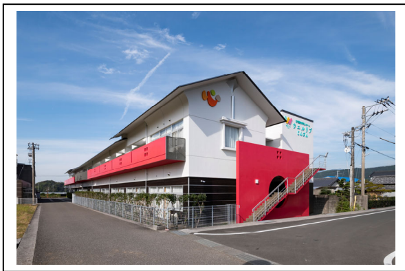
東方面より建物を望む
