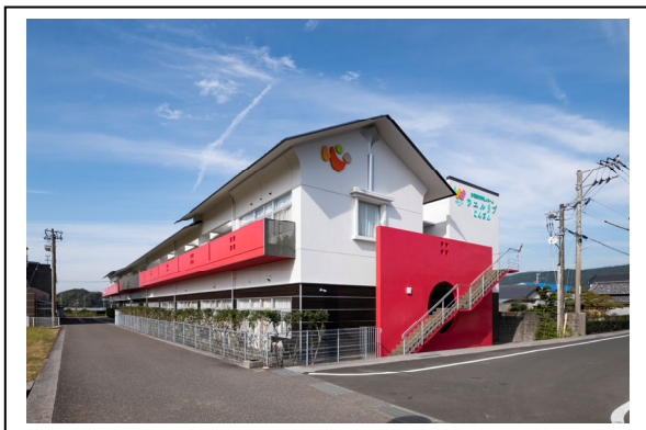
東方面より建物を望む
